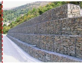
Fig: 1.6 Gabion wall
